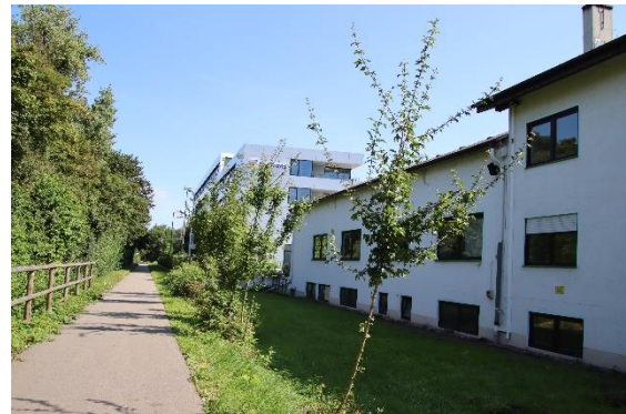
Photo 13 Blickrichtung N vom Radweg aus (Rückseite)
