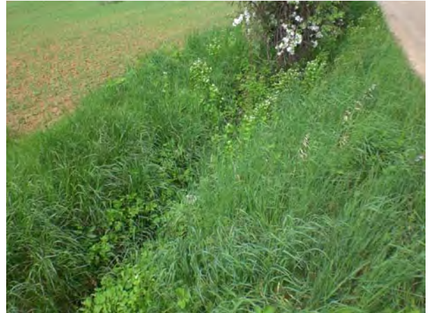
Abb. 9: Entwässerungsgraben (12.61), Flst. Nr. 3049
