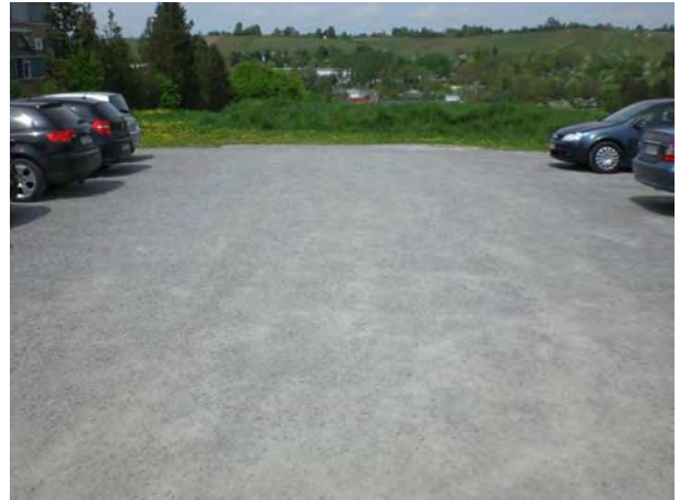
Abb. 17: Stellplätze mit wasserdurchlässigem Belag (60.23), Flst. Nr. 3045
