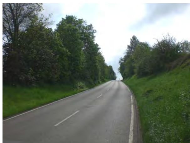
Abb. 8: Affalterbacher Straße, Feldhecke mittlerer Standorte
