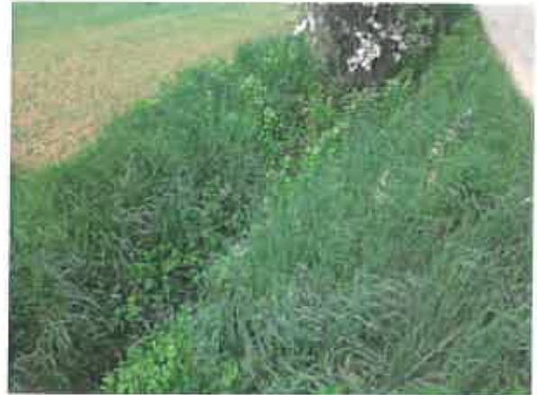
Abb. 9: Entwässerungsgraben (12.61), Flst. Nr. 3049
