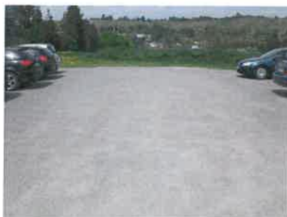
Abb. 17: Stellplätze mit wasserdurchlässigem Belag (60.23), Flst. Nr. 3045
