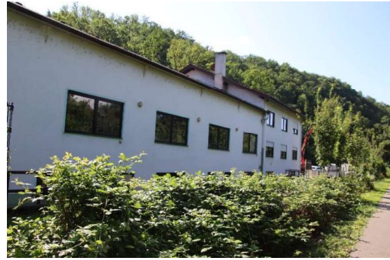
Photo 9 ehem. Reifenhandel Gewerbebetrieb (Rückseite)
